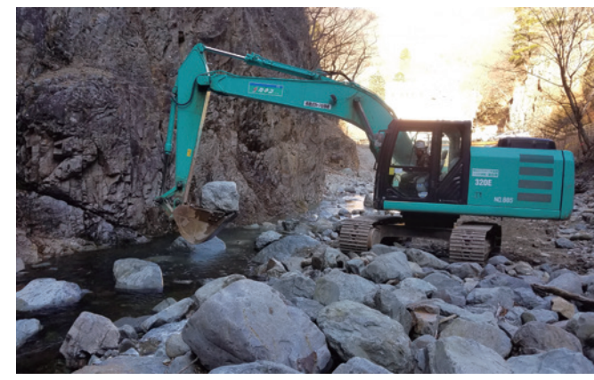
写真4 日光砂防事務所によるイワナ保全のための巨石投入
