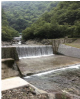
写真1 D川上流域の堰堤
